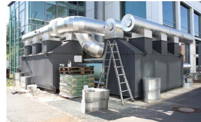
Hochtemperaturspeicher mit Sand als Speichermaterial während des Aufbaus
